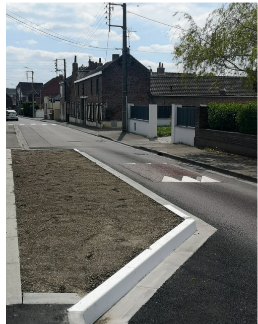
Installations de plateaux ralentisseurs et de chicanes pour limiter la vitesse
